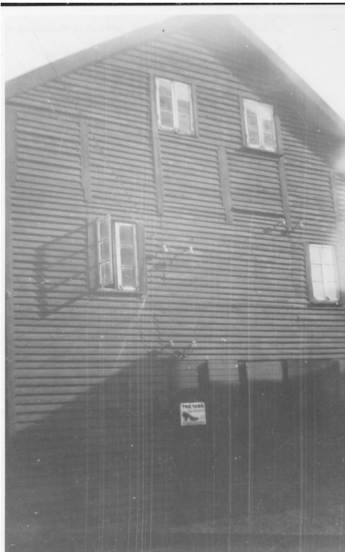
Foto: 7 Enligt texten på fotografiet, som är taget 1933-09-18, föreställande magasinsbyggnaden skulle den vara uppförd på 1880-talet och innehålla ett stall på kortsidan mot bygganden på storgatan. I detta skulle Dan. Lundgren haft sex hästar. [R3]
