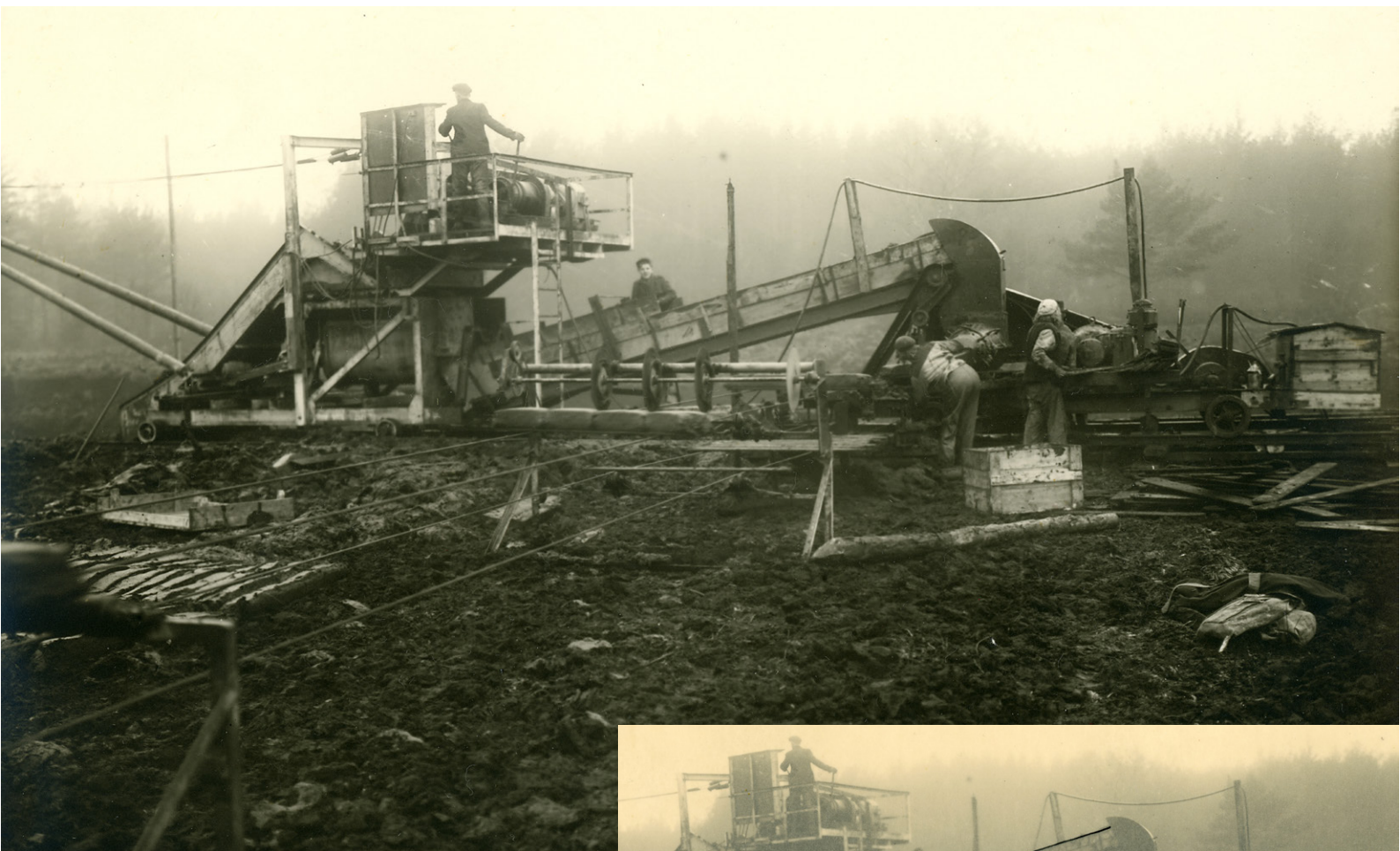
Torvverk med Berlin-släpskopa (utanför bild), troligen tidigt 1940-tal. Foto: H Berglund, Ljungby. Detta var en metod för maskintorvtillverkning som användes på statsmossarna, se nästa sida. Släpskopan avbuggen på vänster sida i bilden.
